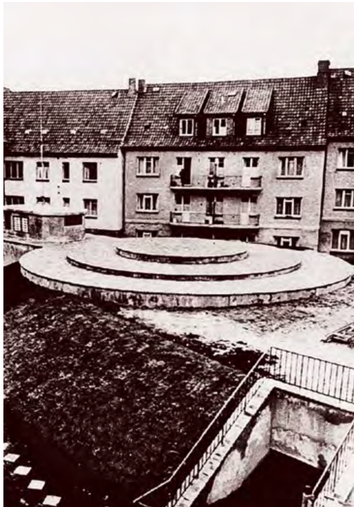
Blick auf das Betondach des Saalkörpers, Februar 1937
