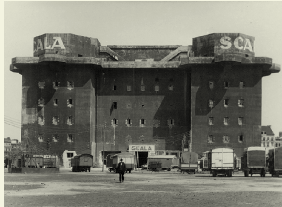
Umnutzung des Flakbunkers auf dem Heiligen- geistfeld
