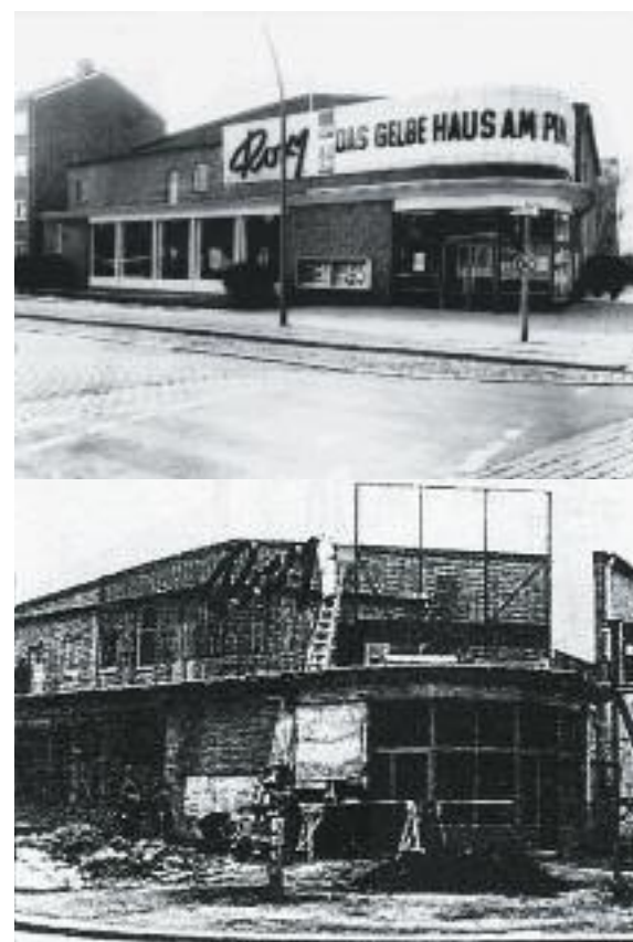
„Roxy Barmbek“ im Frühjahr 1954 als Rohbau (unteres Foto). Der St.Pauli-Thriller „Das gelbe Haus am Pinnsberg“ lief dort Ende Februar 1970. Fotos: Geschichtswerkstatt Barmbek
