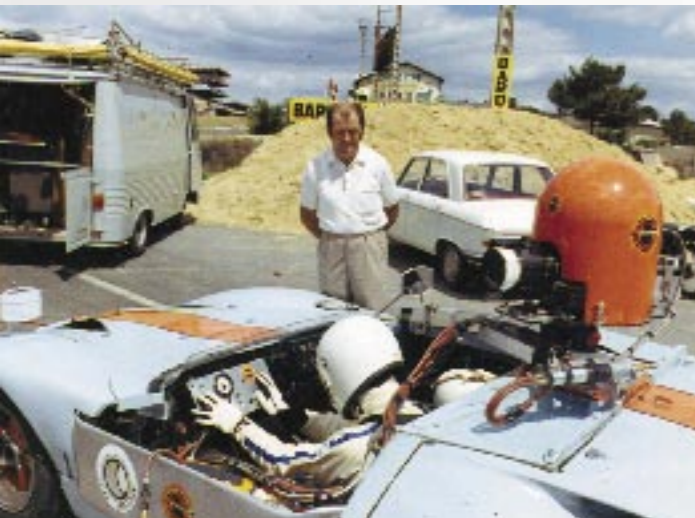
Bunnenberg hatte 1971 bei den Dreharbeiten zu "Le Mans" von John Sturges die Idee, für die Autorennenszenen Kameras auf einem pressluftgesteuertem Schwenkkopf zu installieren. Foto: privat
