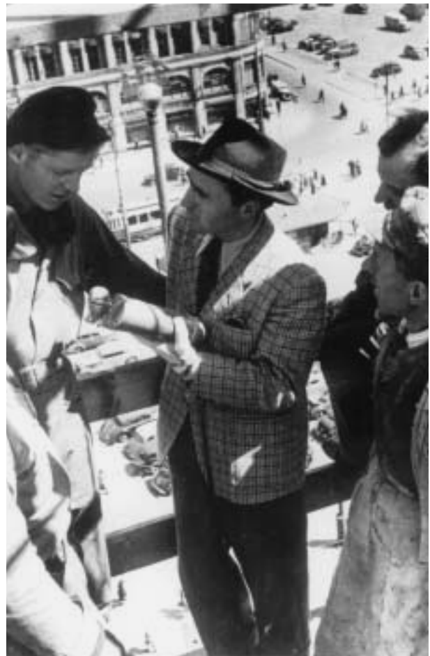
Anfang der fünfziger Jahre: Max H. Rehbein spricht mit Bauarbeitern, die das Hamburger Rathaus von Kriegsschäden befreien.
