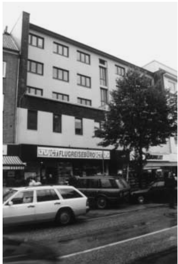
Der Gebäudekomplex heute.
