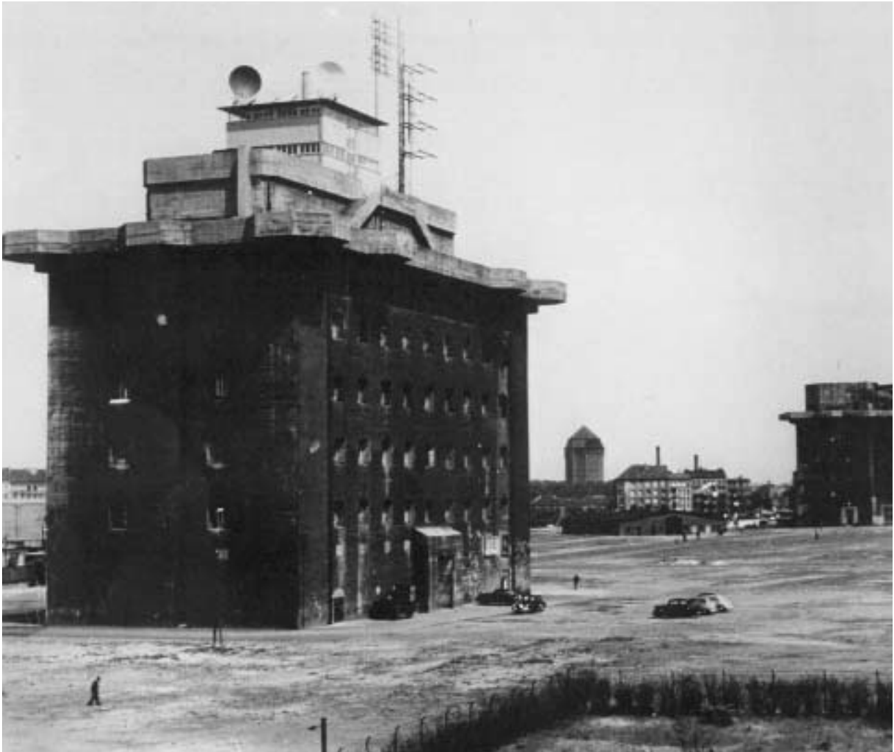
Für das Fernsehen umgebauter Bunker auf dem Heiligengeistfeld, 1951/52.
