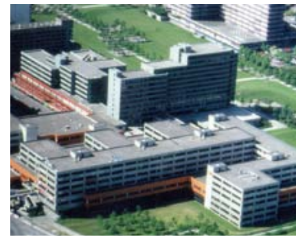
Blick auf das Sat.1 -Gebäude am Mexikoring
