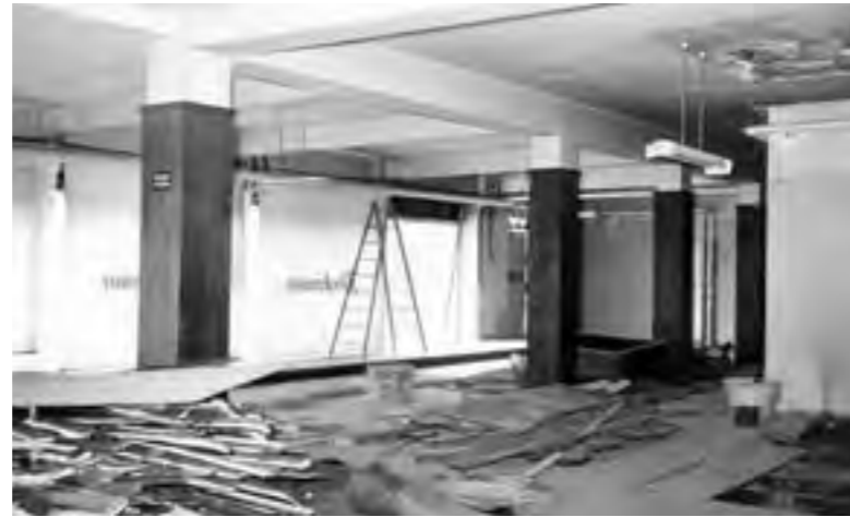
Während der Bauarbeiten für das neue ‚BALI‘-Kino im Souterrain und im ersten Stock des Klockmannhauses Ende Juli 1973. Foto: Stratmann/Conti-Press
